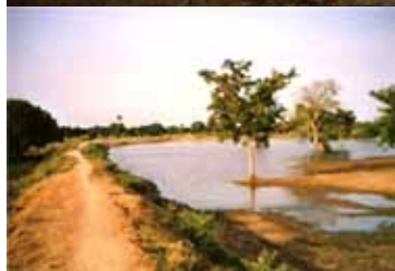
LE BARRAGE, QUI A ÉTÉ RECONSTRUIT, EST RÉ-AMÉNAGÉ RÉGULIÈREMENT
